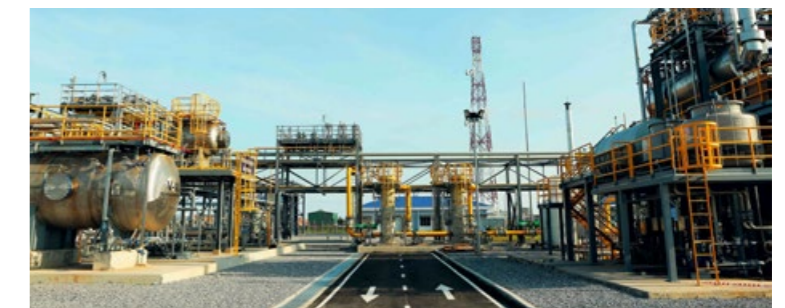
Nhà máy xử lý Khí Tiên Hải của PV GAS cung cấp khí cho CNG Việt Nam tại KCN Tiên Hải, Thái Bình.
