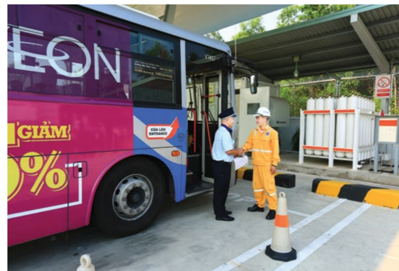
Trạm cấp khí trung tâm của CNG Việt Nam - KCN Mỹ Phước 3, Bình Dương.
