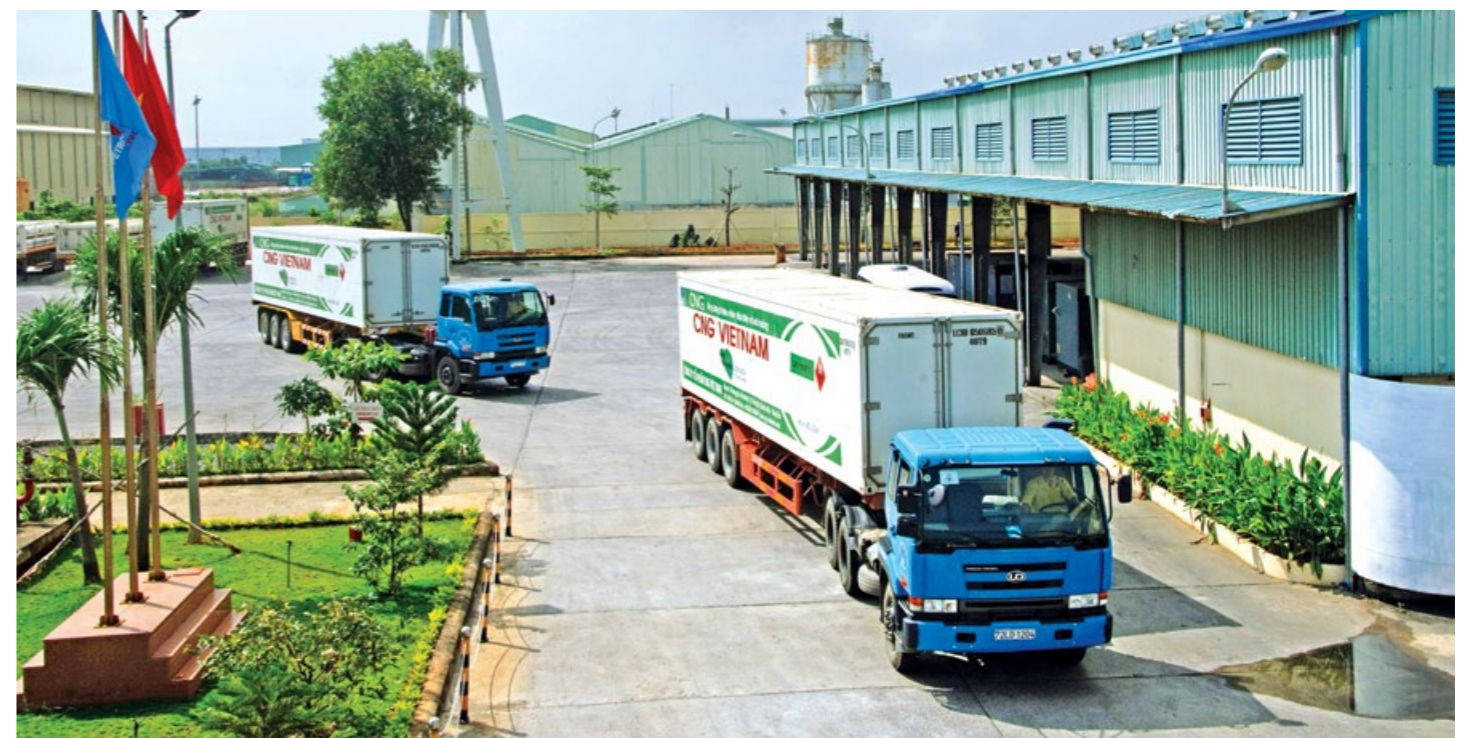
Nhà máy sản xuất khí CNG của CNG Việt Nam tại KCN Phú Mỹ I, huyện Tân Thành, Tỉnh Bà Rịa – Vũng Tàu, công suất 95 triệu Sm 3 .
